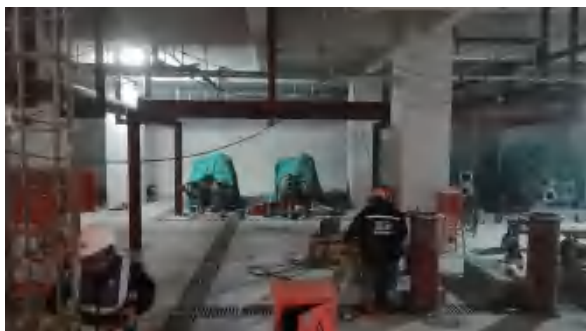
机房施工中现场照片
