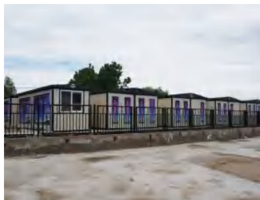
佟家坟村集中供暖地能热泵站
