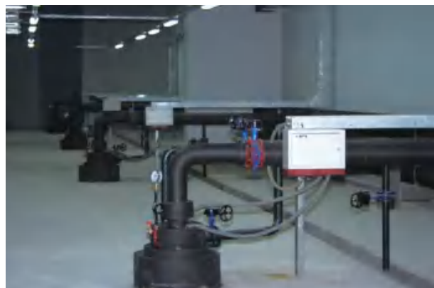
图 12 建在国家大剧院地下室的 100% 同井回灌的单井循环换热地能采集井
