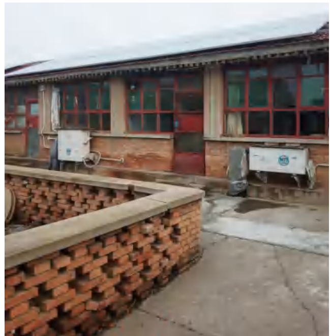
地能热宝室外机、屋顶太阳能发电
