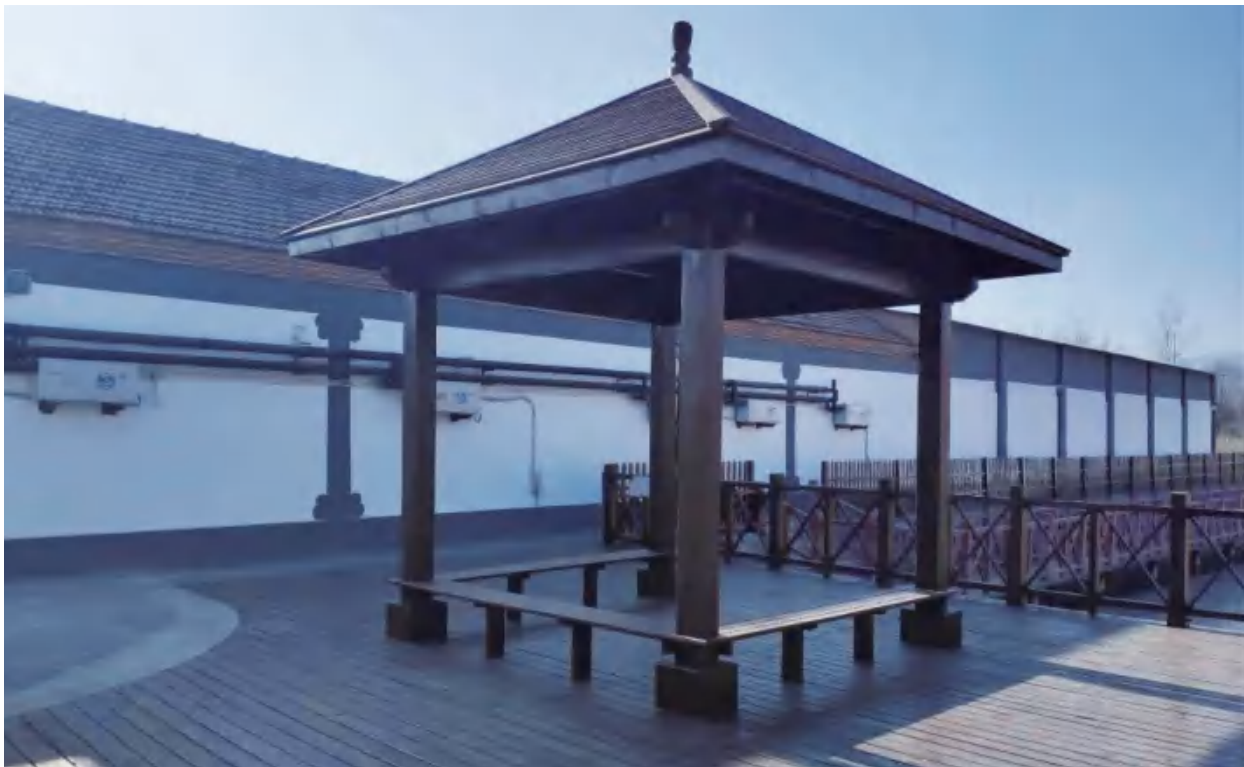
罗家坟村安装在外墙的地能热宝室外机
