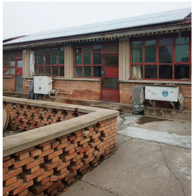
地能热宝室外机、屋顶太阳能发电
