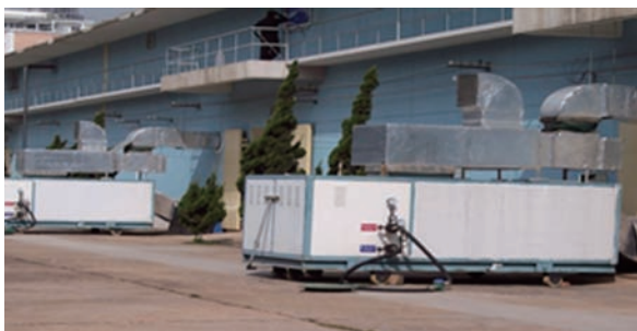
恒有源单井循环换热地能采集井和可移动的热泵装置
