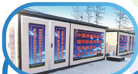
高效電替煤集中供暖機房
