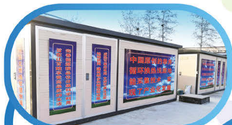
高效電替煤集中供暖機房
