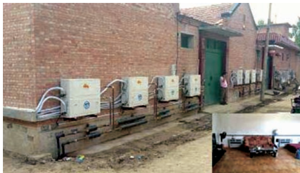
北京上庄镇西闸村：整村高效电替煤改造，分间使用，分户计量
