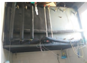
图 2（左）改造前蓄热水箱（卫生间内架空安装）
